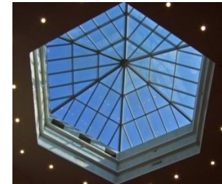
Рис. 2. Зенитный фонарь зимнего сада изнутри
