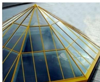
Рис. 1. Зенитный фонарь зимнего сада снаружи
