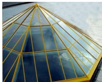
Рис. 1. Зенитный фонарь зимнего сада снаружи
